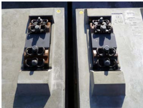
Einbausituation BSP FF-B-1, Beton
