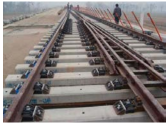
System 300 W, Einbausituation
