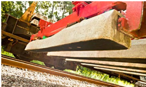
Besohlte Betonschwelle bei Einbau ins Streckengleis
